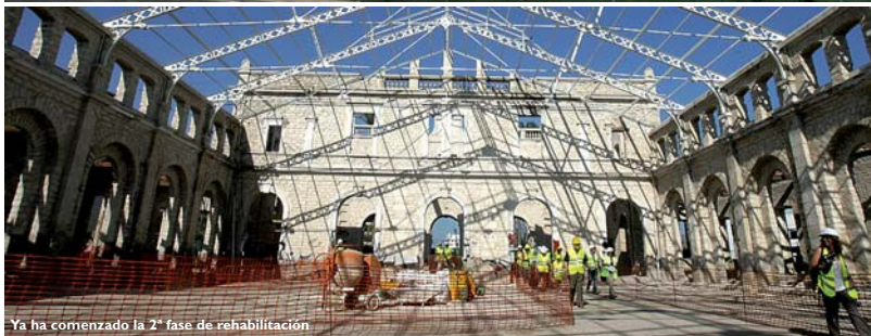
Ya ha comenzado la 2ª fase de rehabilitación
