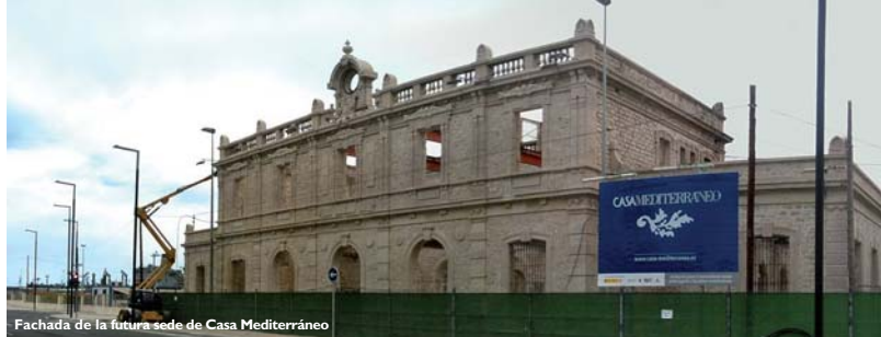
Fachada de la futura sede de Casa Mediterráneo
